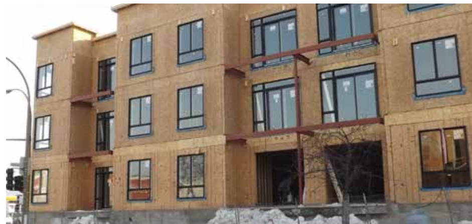
Le Laurent-Fleury en construction sur le boulevard St-Laurent, coin Fleury
