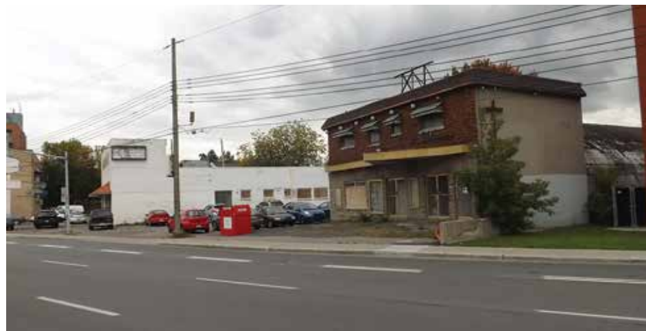
Emplacement de la future bibliothèque interarrondissement boul. Henri-bourassa Est, près du boulevard St-Michel. (Photo : P. Rachiele)
