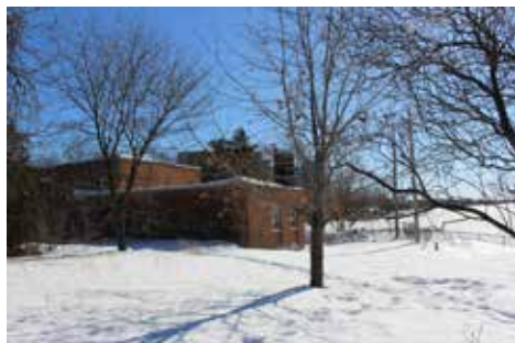
Vue de l'immeuble sur le terrain de l'ancien Fort Lorette maintenant propriété de la Ville de Montréal (Photo : jdv - Éloi Fournier)
