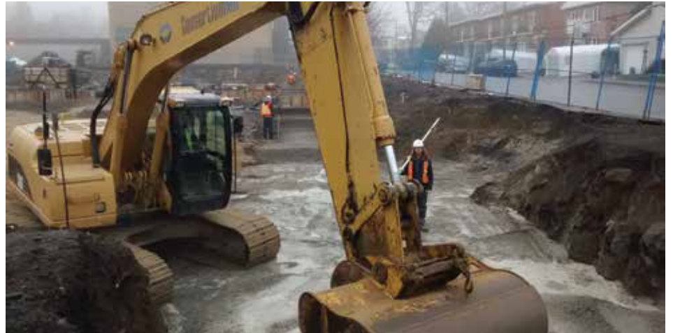
Comme annoncé dans nos Actualités Web, l'école St-François-de-Laval sera agrandie. Les travaux ont déjà débuté comme on peut le constater sur la photo prise le 25 novembre dernier (Photo : Philippe Rachiele)
