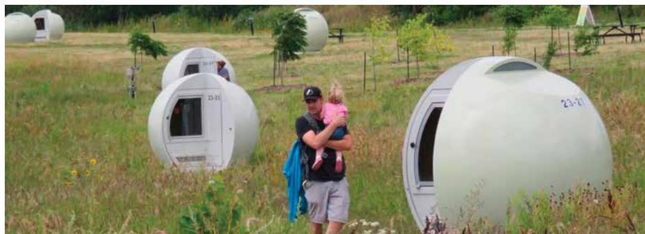
Sphères au parc Frédéric-Back qui protègent les puits de captations de gaz de l'ancien dépotoir (Photo : jdv - P. Rachiele)
