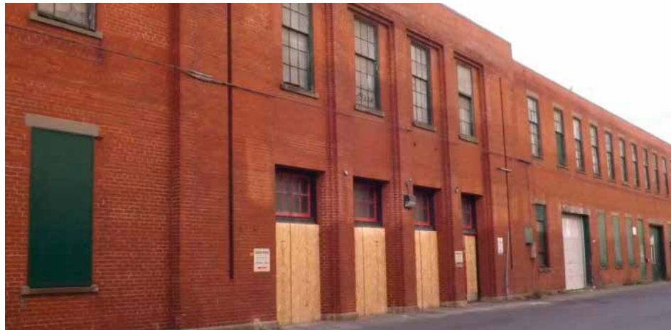
Vue partielle de l'ancienne usine d'armement de la Montreal Works avant sa démolition (Photo : jdv - P. Rachiele)
