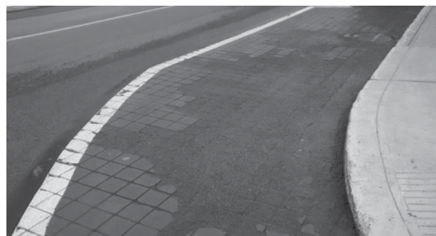
Saillie endommagée après trois ans d'usage (Photo : jdv-Philippe Rachiele)
