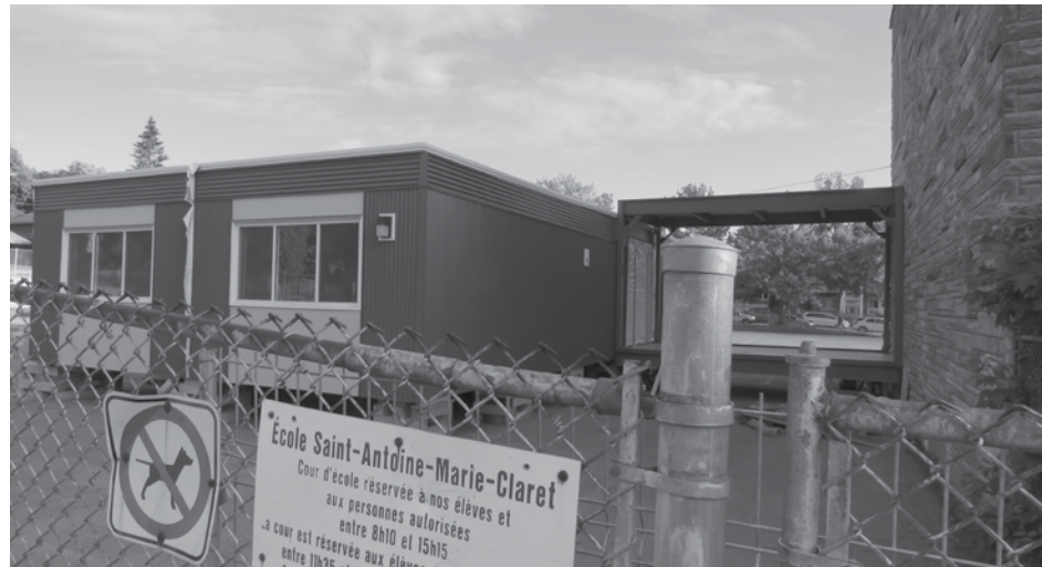
Une des nouvelles classes préfabriquées présentement installées à l'école Saint-Antoine-Marie-Claret (Photo : jdv - Philippe Rachiele)
