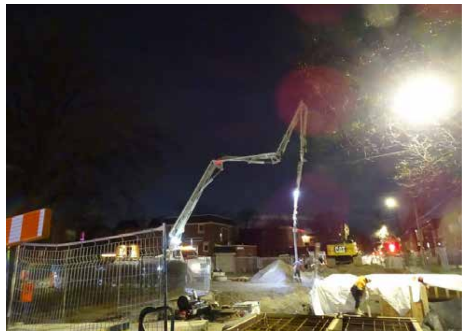
Travaux d'aqueduc angle Prieur et Clark en 2020 (Photo : jdv - Philippe Rachiele)
