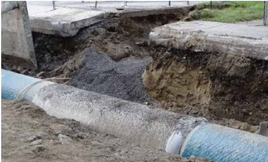
Les travaux d'aqueduc sont financés par le programme FIMEAU (Photo : jdv - Philippe Rachiele)
