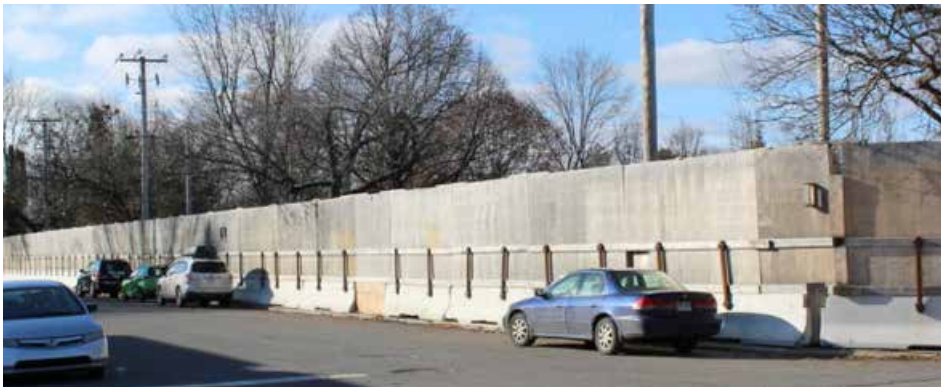
Site de la construction du bassin Lavigne dans Cartierville (Photo : Archives jdv)
