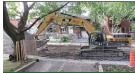
Travaux d'infrastructure rue Clark à l'été 2020 (Photo : JDV - Philippe Rachiele)
