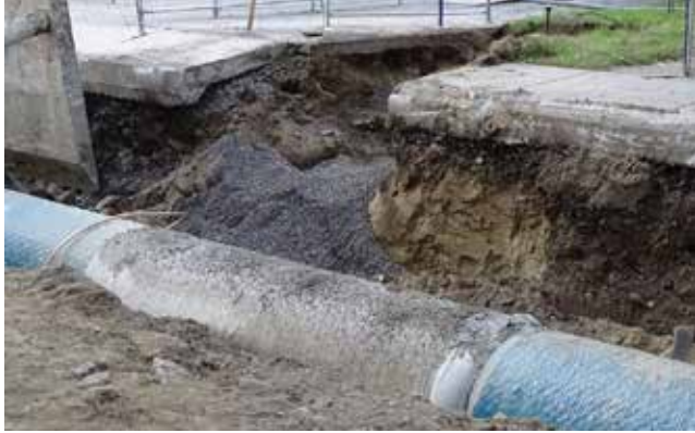
Les travaux d'aqueduc sont financés par le programme FIMEAU (Photo : jdv - Philippe Rachiele)
