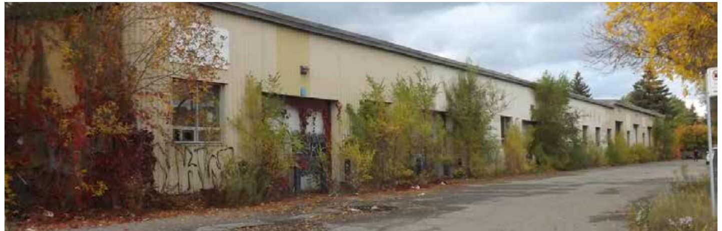
Anciens entrepôts du ministère des Transports du Québec sur Henri-Bourassa Ouest avant leur démolition (Photo : Archives - jdv)
