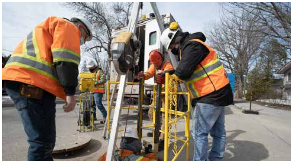
Un égoutier descend afin de réparer un tuyau. Ses collègues tiennent l'échelle afin de faciliter sa descente. (Photo : JDV - François Robert-Durand)
