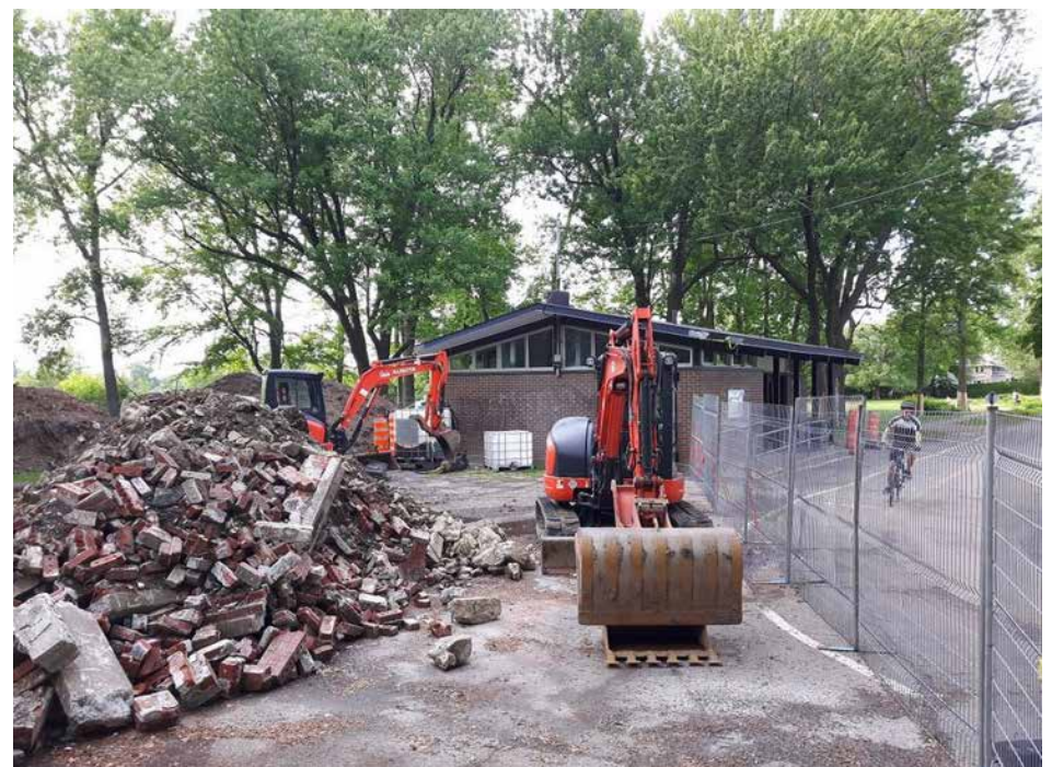
Travaux au parc Nicolas-Viel en 2019. (photo : Philippe Rachiele, archives JDV)
