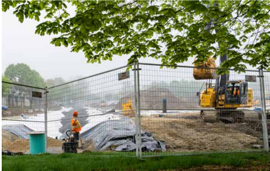
De nombreux parcs sont en chantier dans l'arrondissement. Le plan directeur devrait permettre de planifier les travaux à venir. (Photo : François Robert-Durand, JDV)
