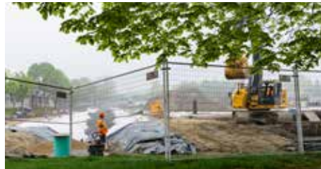
L'étang du parc Ahuntsic en cours de réfection en mai 2022. (Photo : JdV -Carla Geib)
