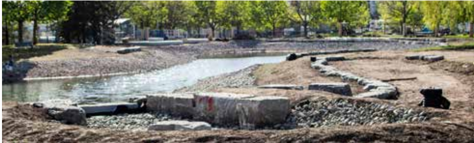
De nombreux parcs sont en chantier dans l'arrondissement. Le plan directeur devrait permettre de planifier les travaux à venir. (Photo : François Robert-Durand, JDV)
