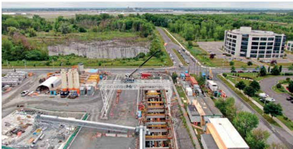
Station du REM au Technoparc avec l'aéroport en arrière plan (Source : ADM)
