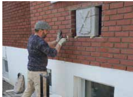
Le tailleur de pierre à l'oeuvre à la maison de Sylvain Bruneau (photo : courtoisie)
