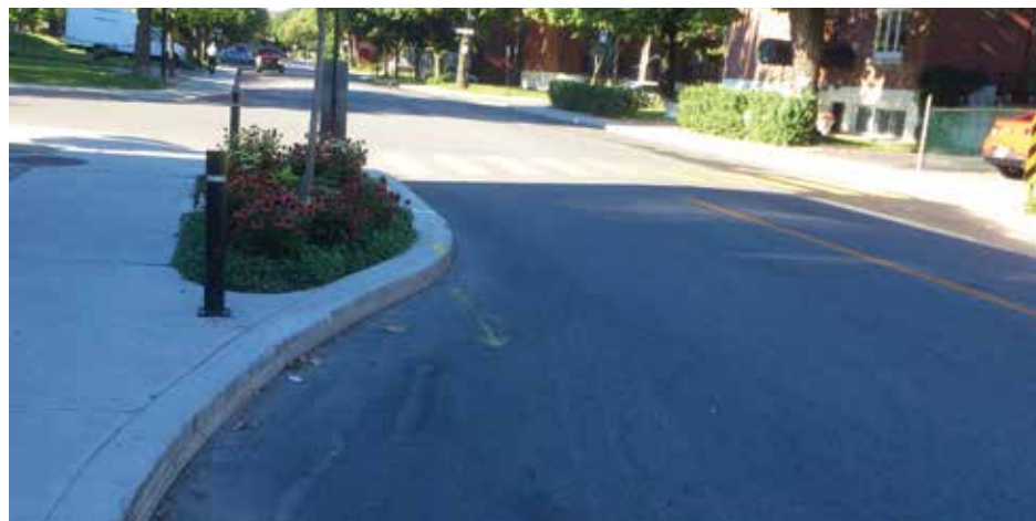
Une saillie qui rétrécit la distance au passage piétonnier sur Fleury Ouest (Photo : Philippe Rachiele).
