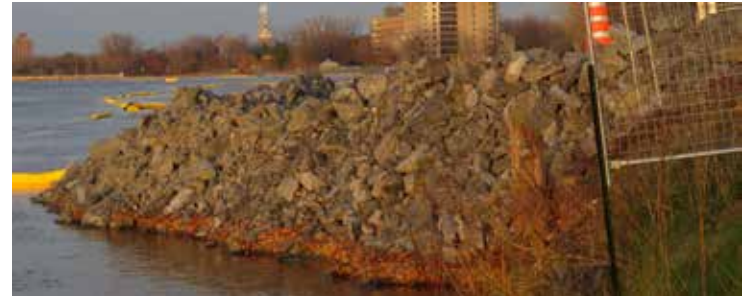
Enrochement derrière l'école Sophie-Barat pour soutenir le mur Simon-Sicard (Photo : jdv – P. Rachiele)
