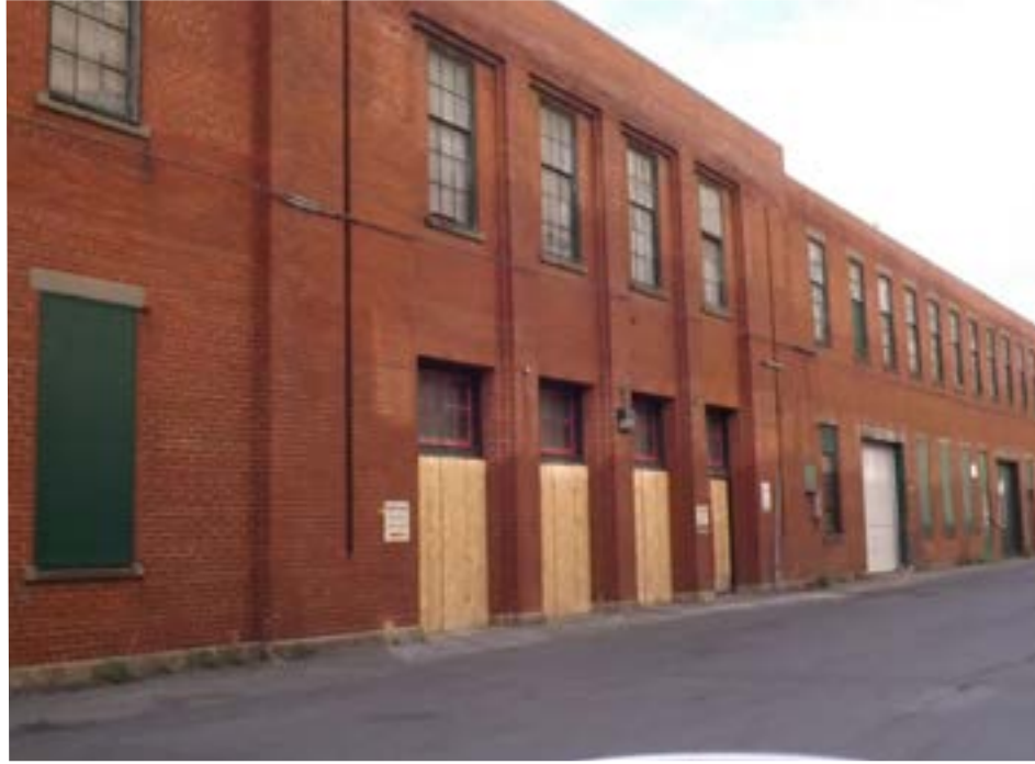
L'usine Montreal Works au moment de sa démolition. (Photo: Philippe Rachiele, JDV)
