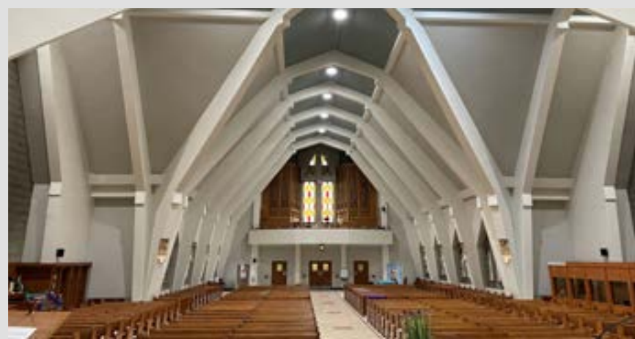
Une église et des œuvres d'art en bon état. Les rénovations de l'église Saint-Paul-de-la-Croix sont terminées. (Photo : Marie-Hélène Paradis, JDV)
