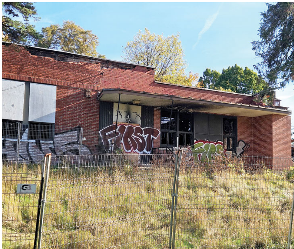
La décontamination des sols ne fait pas partie des travaux de démolition. Photo : Benoît Dosseh / JDV.
