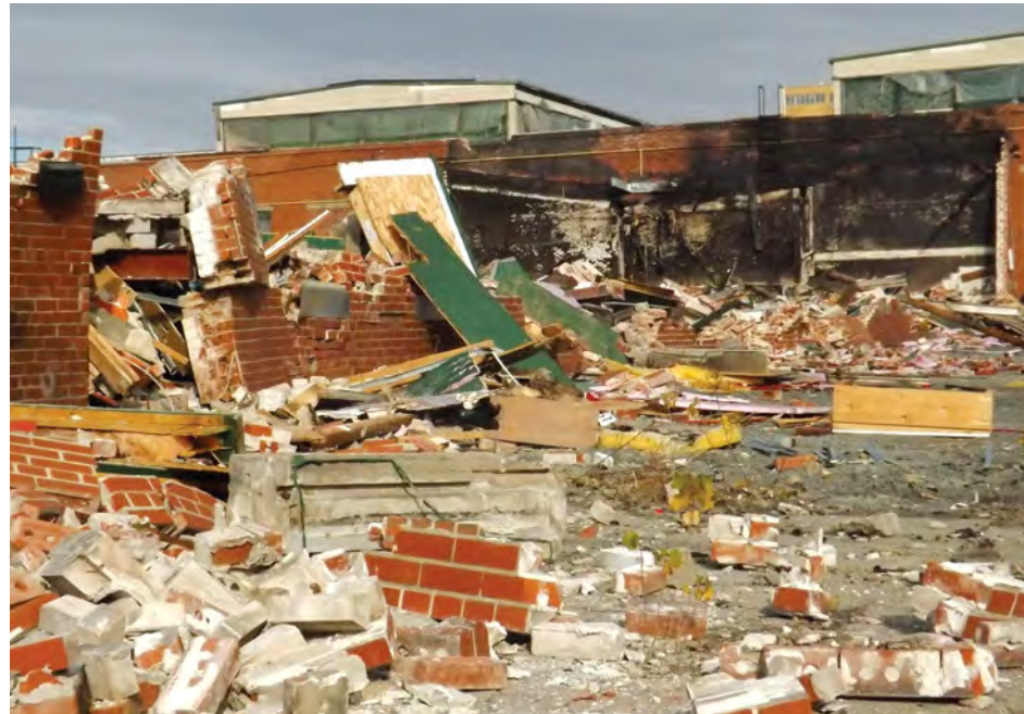
Démolition de l'usine Montreal Works. Photo : Archives / JDV
