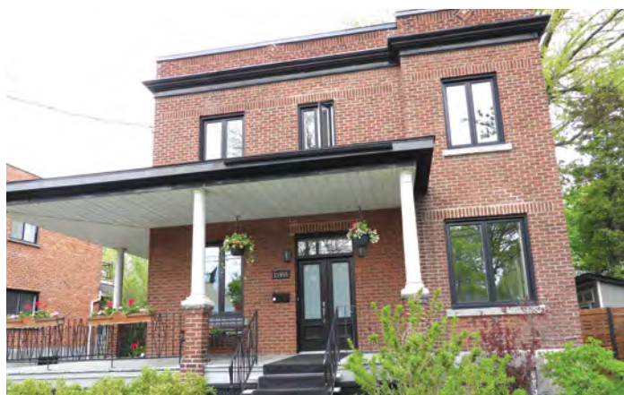
Maison en brique rouge construite en 1925 par l'architecte Louis Parant.
