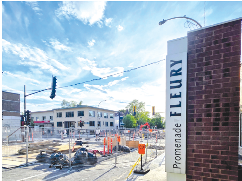
Les déplacements sur la Promenade Fleury seront perturbés par les travaux jusqu'au printemps.
